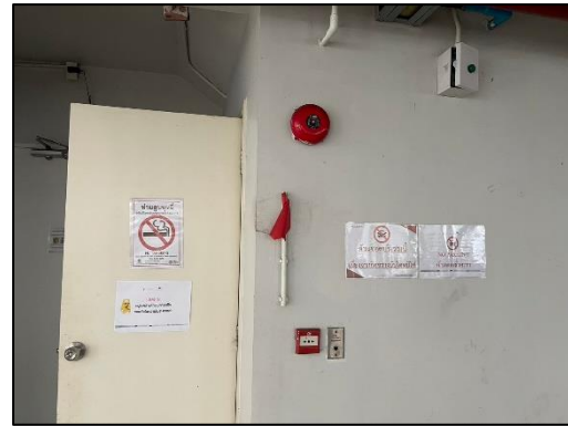
อุปกรณ์ส่งสัญญาณให้หนีไฟเป็นสัญญาณแบบกริ่ง
