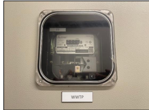
รูปที่ 9 ระบบบำบัดน้ำเสียและมิเตอร์ระบบบำบัดน้ำเสีย
