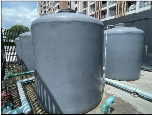
รูปที่ 12 ถังเก็บน้ำสำรองชั้นใต้ดินและดาดฟ้า
